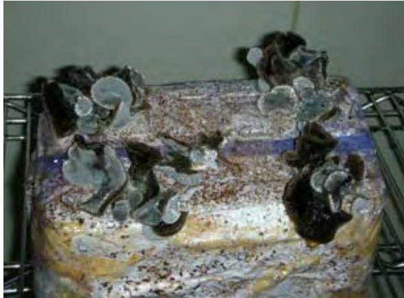
図-41 空調施設での発生状況
