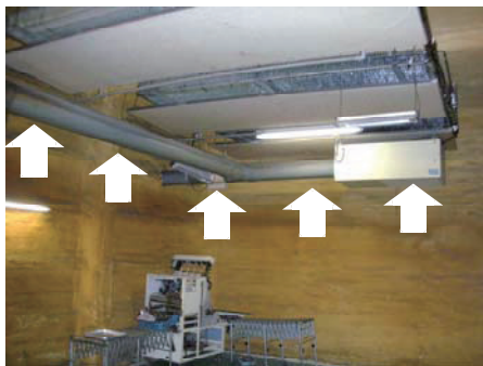
図-3 榛東村施設改修前
