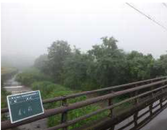
河川の整備状況：着手前 粕川（前橋市粕川町室沢）
