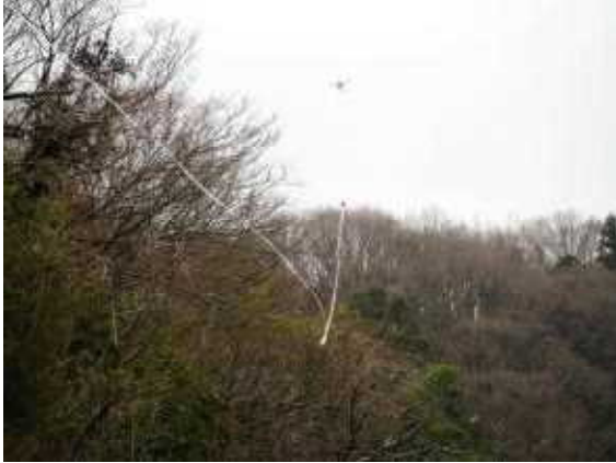
ドローンによるテープ張りの様子
