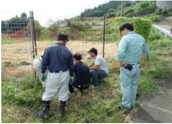
侵入防止柵の点検作業 (上丹生上地区)
