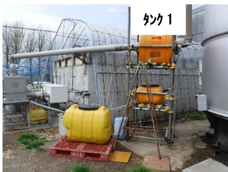
写真1 前処理装置(タンク 1)設置
