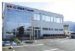
高陽精工株式会社様: 本社外観
