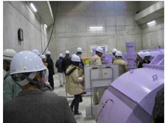
(新利南発電所地下建屋の様子)
