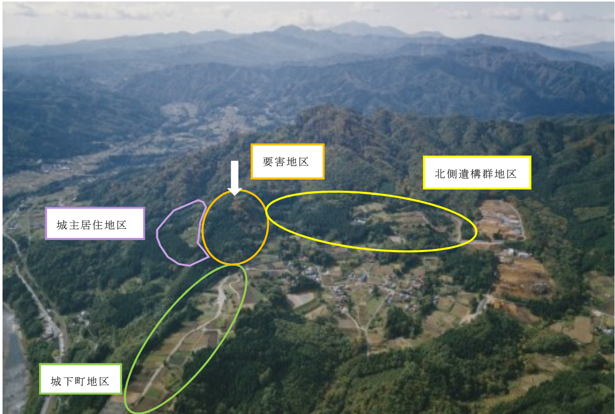
岩櫃城跡 俯瞰（北東より、白矢印が本丸周辺）
