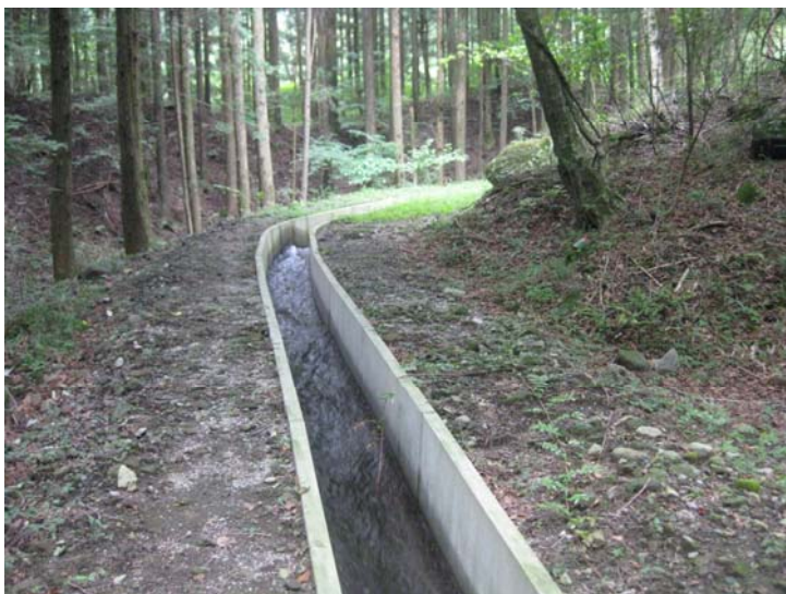
集落で施工した水路
