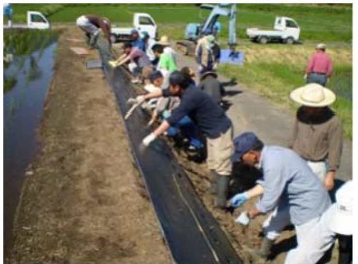
法面に張り芝の種子をまく作業の様子
