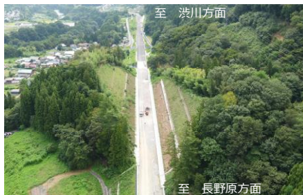
三島地区の工事状況
