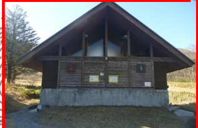
VC駐車場トイレ
