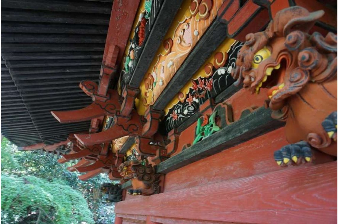
仁王門 上層組物・軒支輪（北から）
