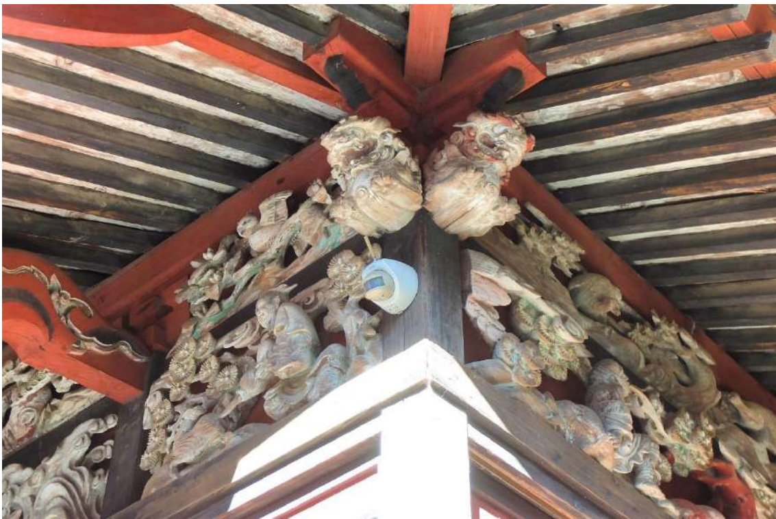
境内社金刀比羅宮拝殿 身舎隅柱の彫刻・組物（北西から）
