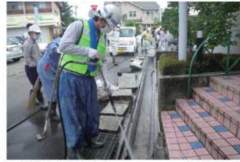
● 側溝の汚泥の除去
