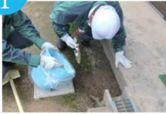
● 民家の軒下・雨樋の清掃
