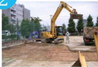
● 校庭表土の削り取り
