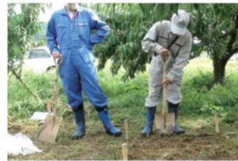
● 庭土等の土壌の削り取り
