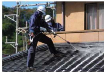
● 建物の屋根等の洗浄
