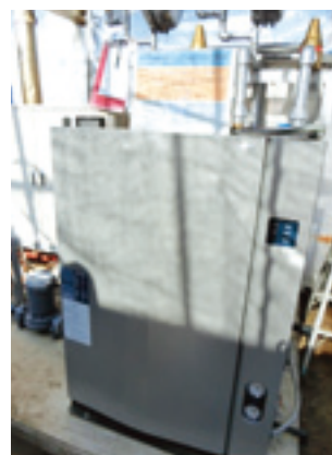
地下水用ヒートポンプ
