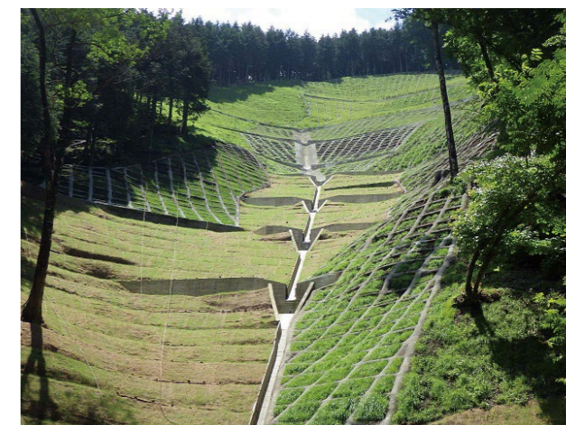
施工事例：崩壊のり面の緑化
