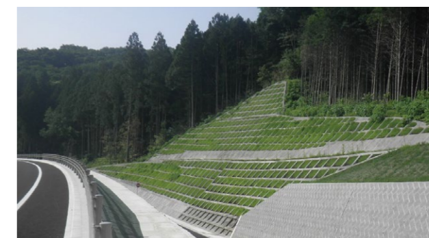
施工事例：上信自動車道
