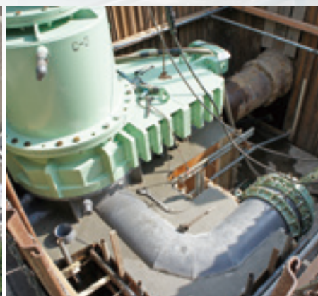
老朽管の布設替え工事（渋川工業水道）
