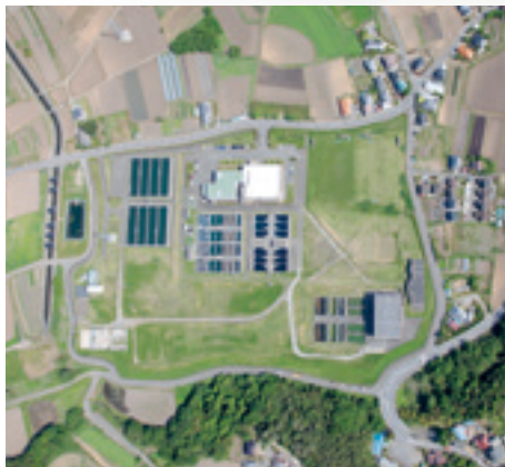
浄水場（県央第二水道事務所）
