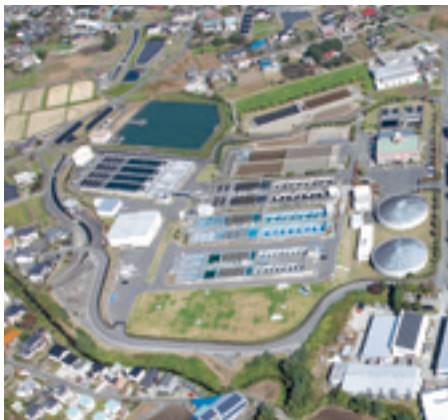
浄水場（県央第一水道事務所）
