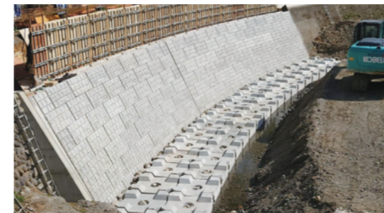
大型護岸ブロック
