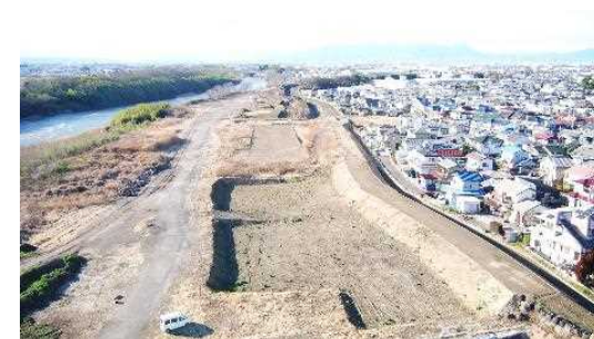
利根川 築堤工事
