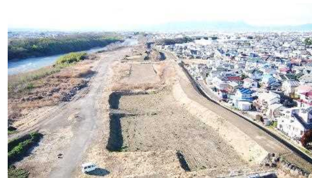
利根川 築堤工事
