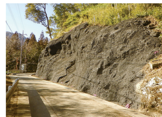
タフネスフォーマー工法（吹付） 施工完了
