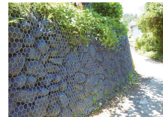
タフネスフォーマー工法（石積み補強） 施工完了
