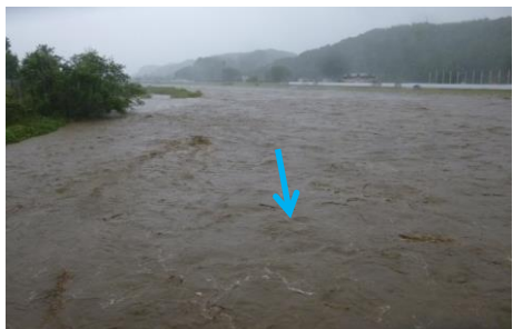
事業前の状況 (令和元年台風19号)
