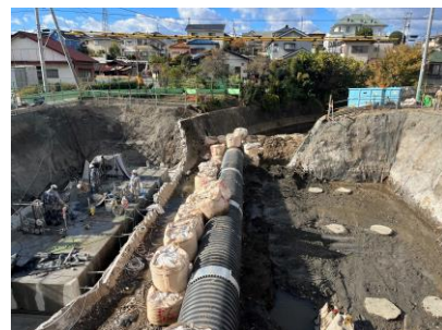
粕川橋 架け替え工事
