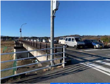
事業前の状況（町屋橋付近）
