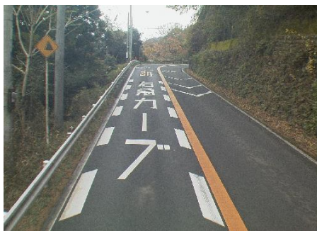
事業前の状況（現道）
