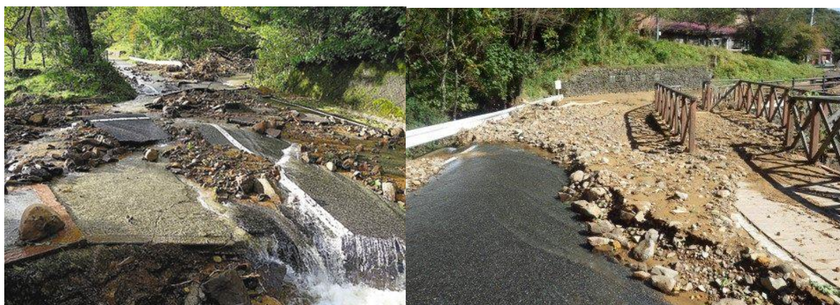
【下仁田町内の被害状況】
