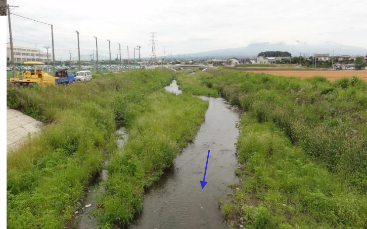
施工後1年(6号橋上流)
