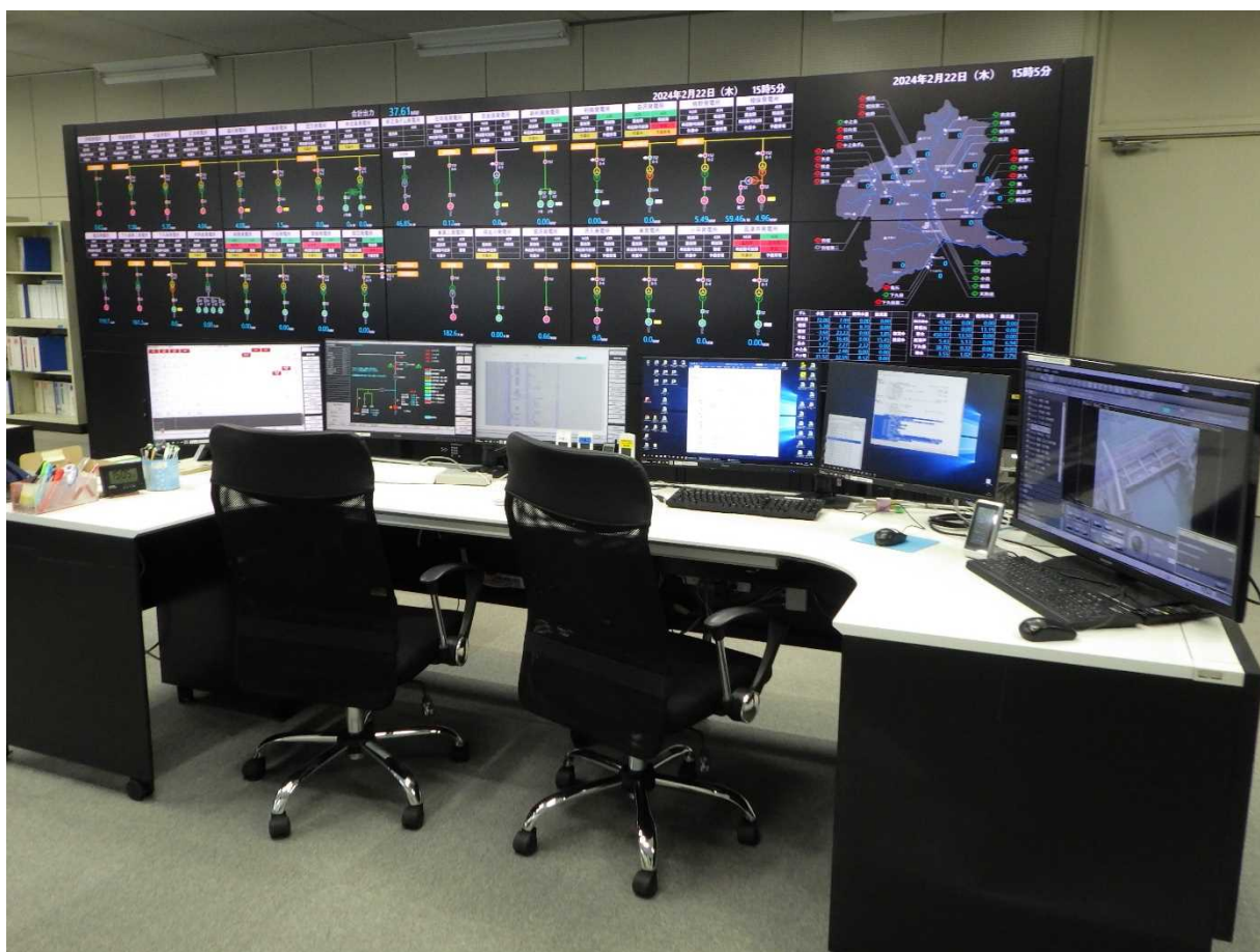
管理総合事務所 更新した遠方監視制御装置
