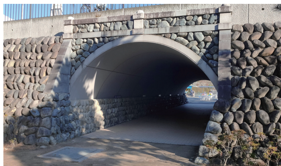
前橋公園のめがね橋(地下道)
