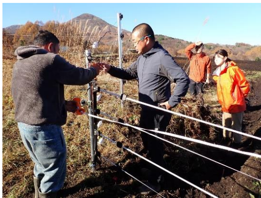
ニホンジカおよびツキノワグマ に対応した恒久電気柵（嬬恋村）
