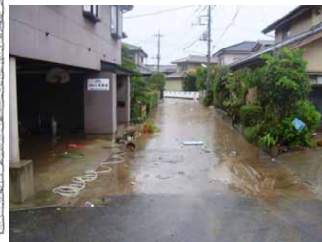
曾木地区浸水状況
