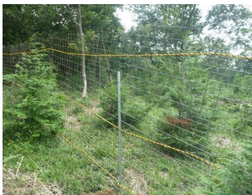
図－1 ワイヤーメッシュ柵設置状況
