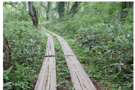
図－1 回収前設置状況
