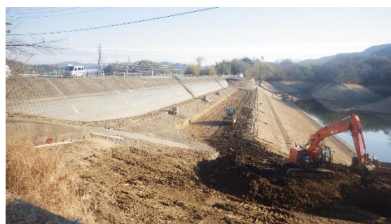
貯水池における耐震補強工事
