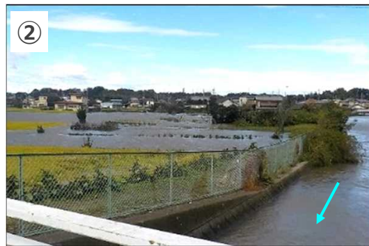
新谷田川放水路沿川の浸水状況
