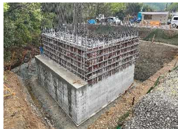
②鍛冶屋川橋下部工(安中市下秋間地内)
