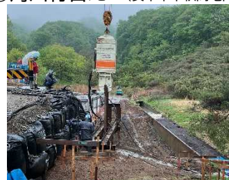
③河川付替え工(安中市下秋間地内)
