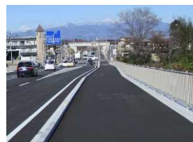
■防護柵の施工事例
