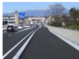
■防護柵の施工事例
