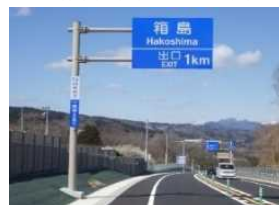
■道路案内標識の施工事例
