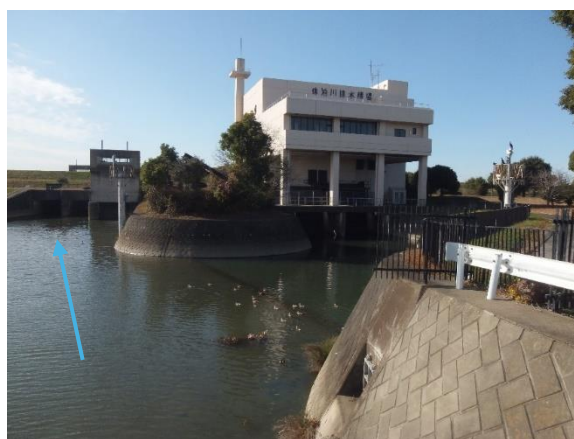
図 1-5 休泊川排水機場（国土交通省）
