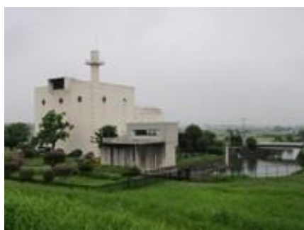
休泊川排水機場全景
