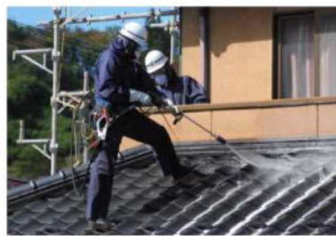
● 建物の屋根等の洗浄
