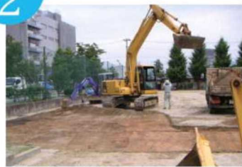
● 校庭表土の削り取り
