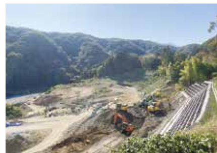
【災害復旧工事現場】
