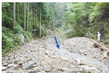
土石流により荒廃した溪流
