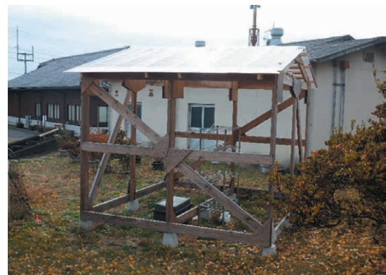
図 場内に製作した小型栽培施設
