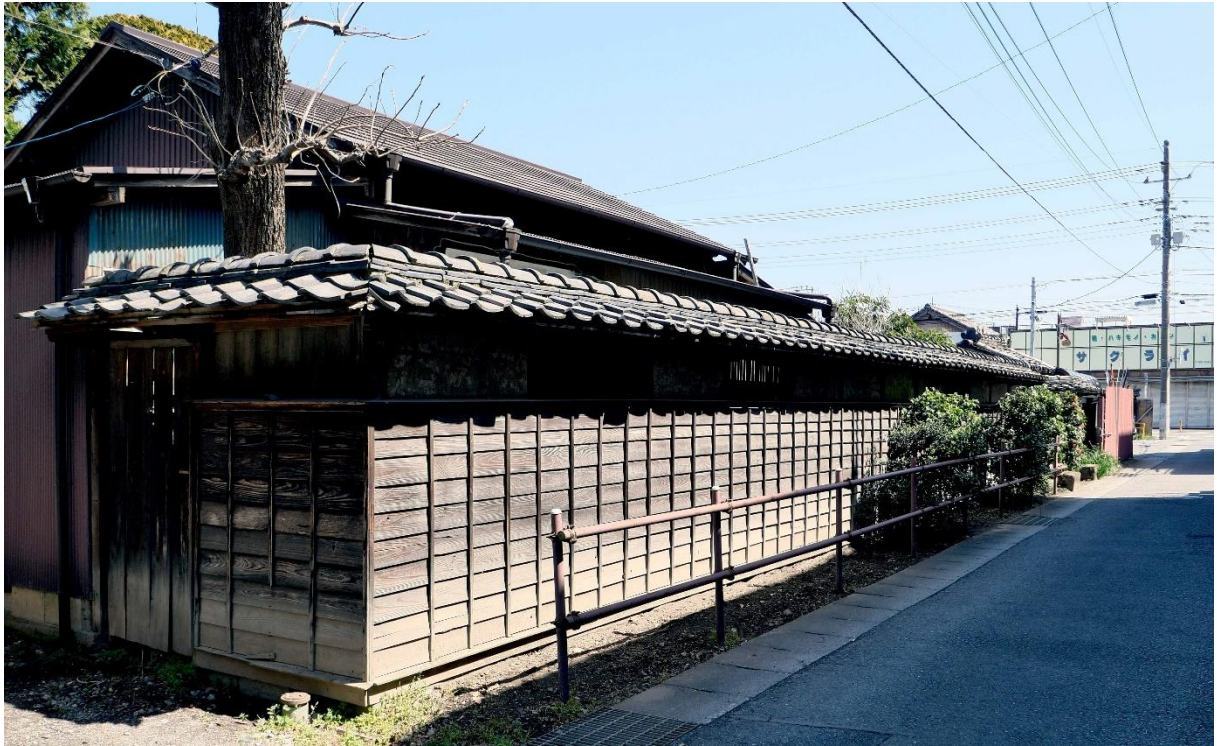
旧相川家住宅裏門及び塀 全景
