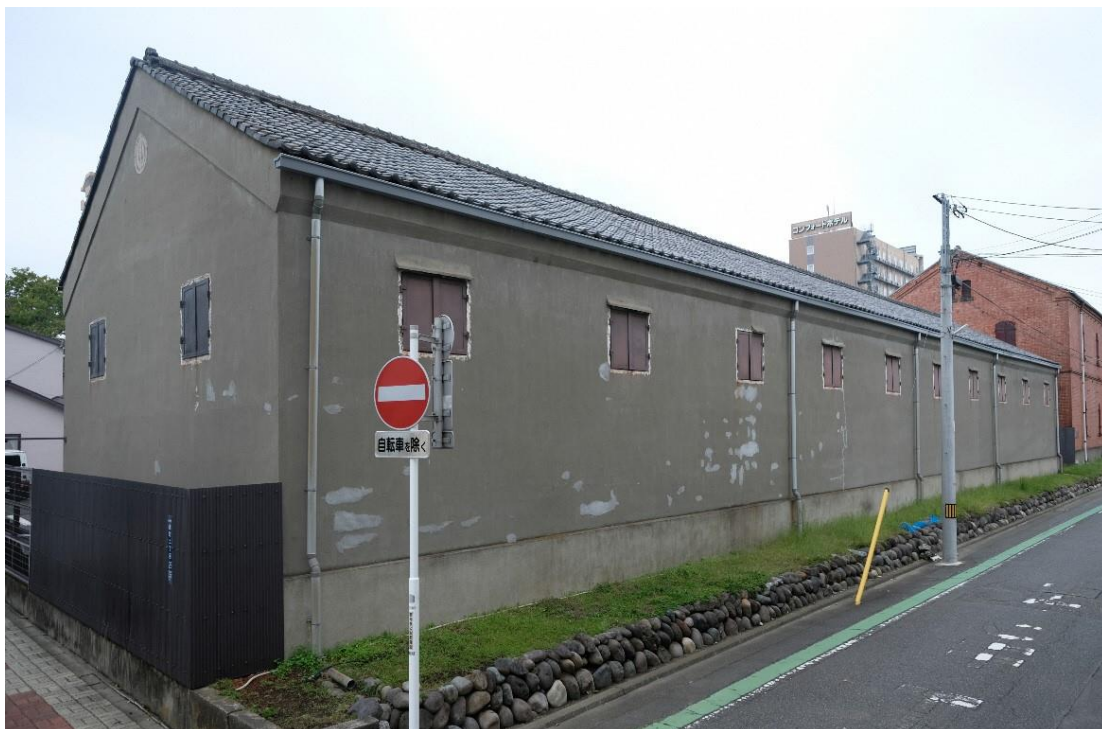
江原本家上毛倉庫 1号棟 外観
