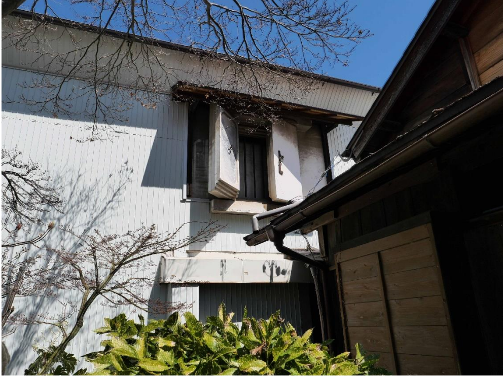
旧相川家住宅土蔵 外観
