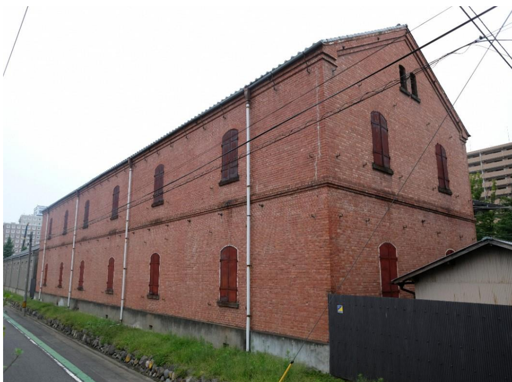
江原本家上毛倉庫 2号煉瓦棟 外観
