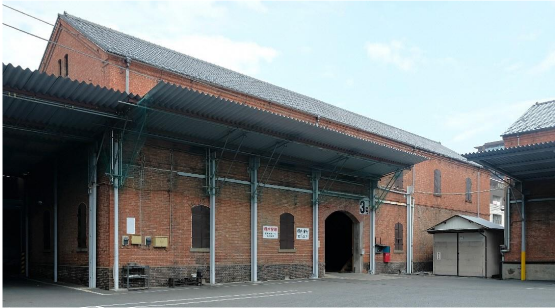
江原本家上毛倉庫 3号煉瓦棟 外觀
