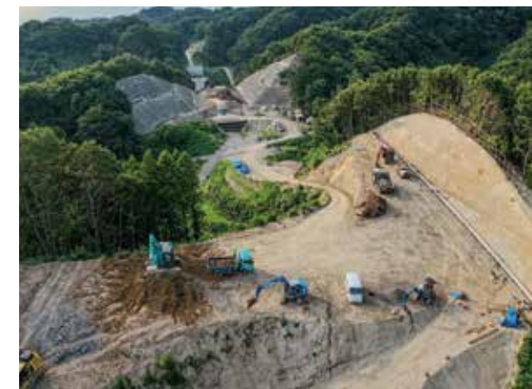
ICT活用工事現場
