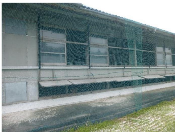
鶏舎全体を覆う防鳥ネットの設置
