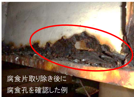
腐食片を取り除いた状態の例(主桁)
