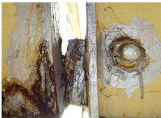
フックの溶接の状態(接合部)
