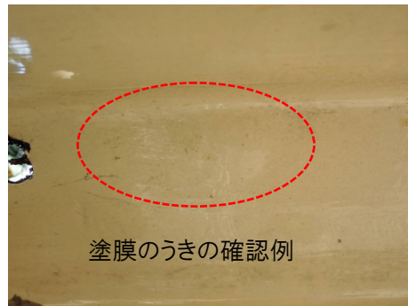
塗装片を取り除いた状態の例(床版)
