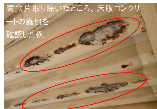
腐食片を取り除いた状態の例(床版)
