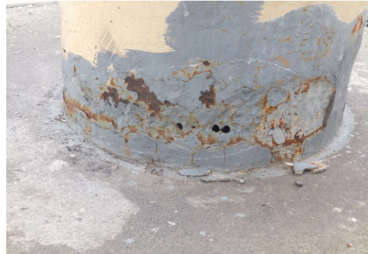
腐食片を取り除いた状態の例(下部)
