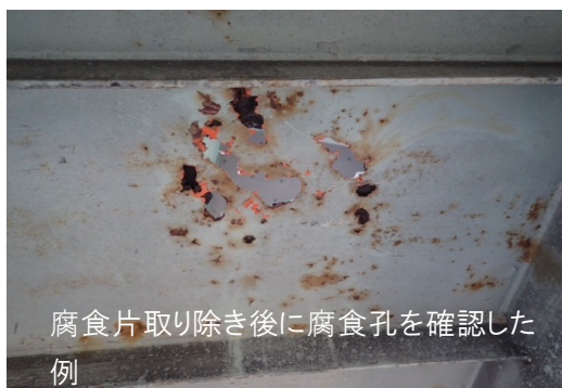
腐食片を取り除いた状態の例(床版)
