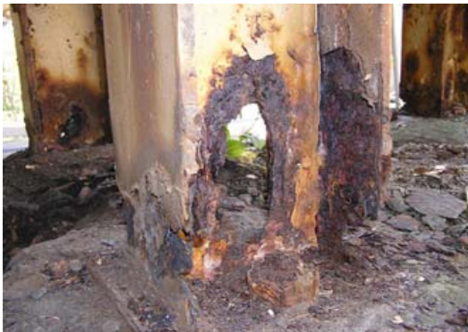
腐食片を取り除いた状態の例(下部)
