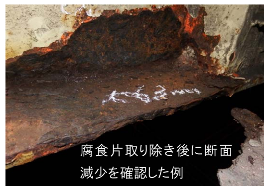
腐食片を取り除いた状態の例(主桁)
