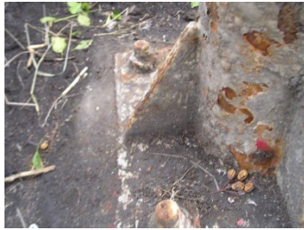
土砂や植生を取り除いた状態の例
