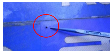
補修用の重ね貼りシート 取付リベットの脱落の例
