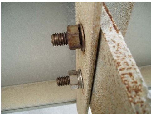
写真-解 8-10 設置後 10 年以内の附属物の変状事例
