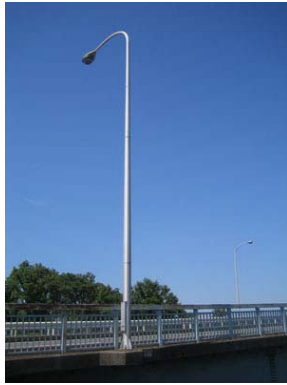
橋梁部に設置
