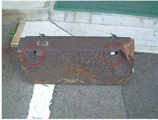
落下照明背面状況
