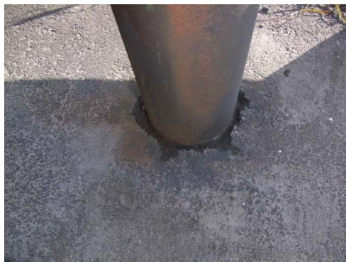
腐食、路面付近での滞水
