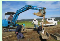
コンクリート水路の更新
