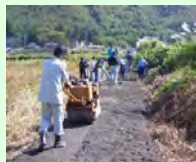
未舗装農道の舗装
