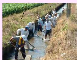
水路の泥上げ
