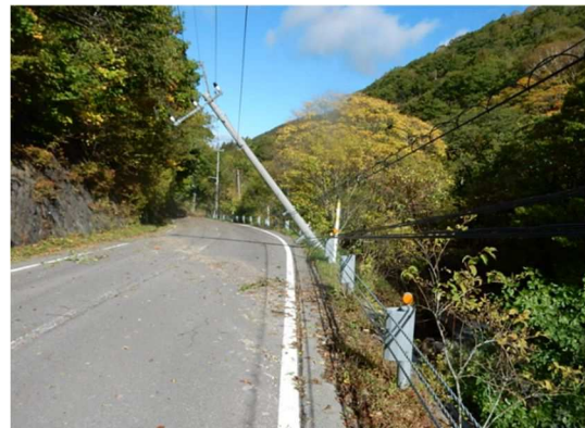
大型台風による電柱倒壊 (2019年(令和元年)台風15号 県道東御孺恋線)
