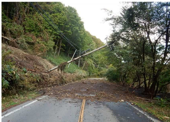
大型台風による電柱倒壊 (2019年(令和元年)台風15号 県道東御孺恋線)
