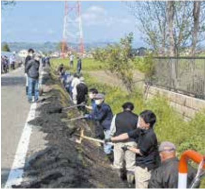
地域住民も参加する水路の泥上げ
