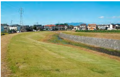
緩傾斜護岸（男井戸川 伊勢崎市）
